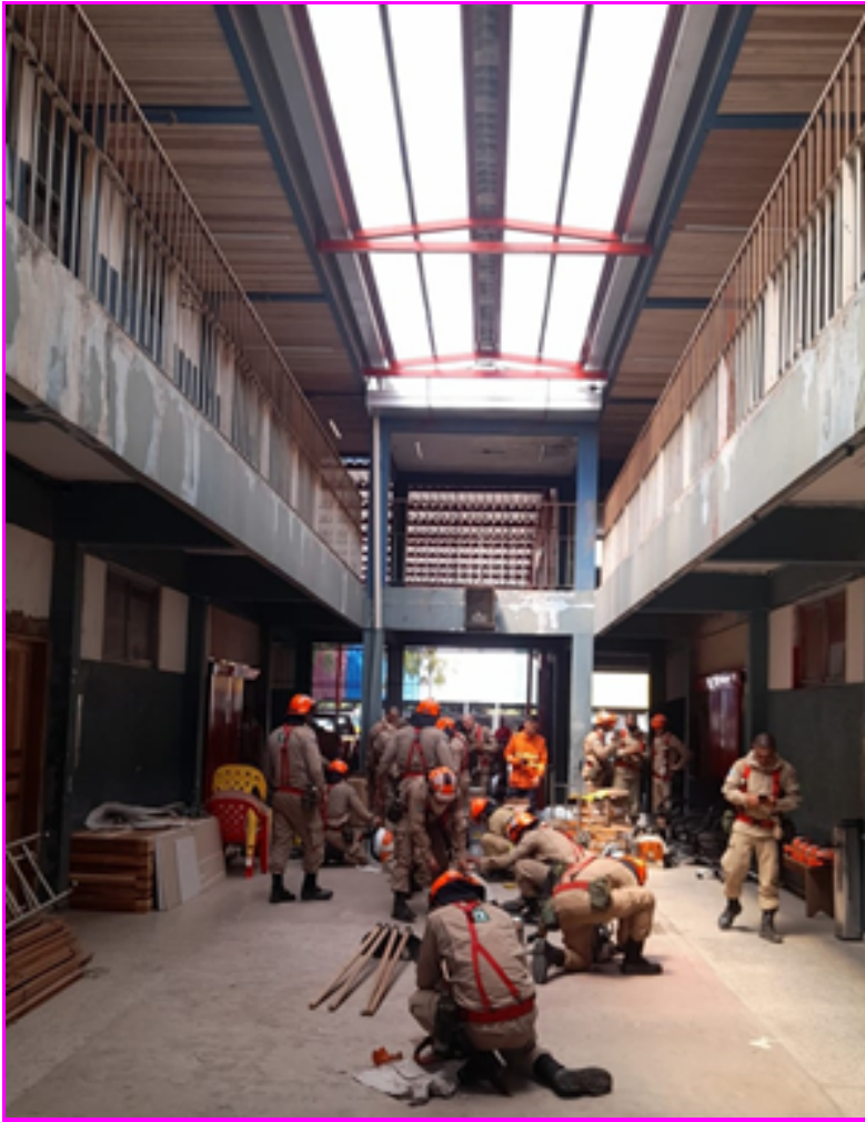
Foto XX - BEA em fase de conclusão da reforma.
