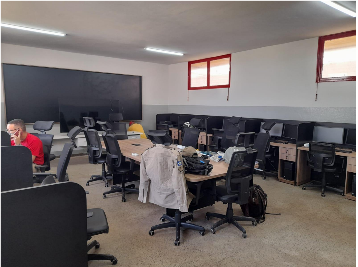
Foto XX - Sala de situação em fase de conclusão de instalação.
